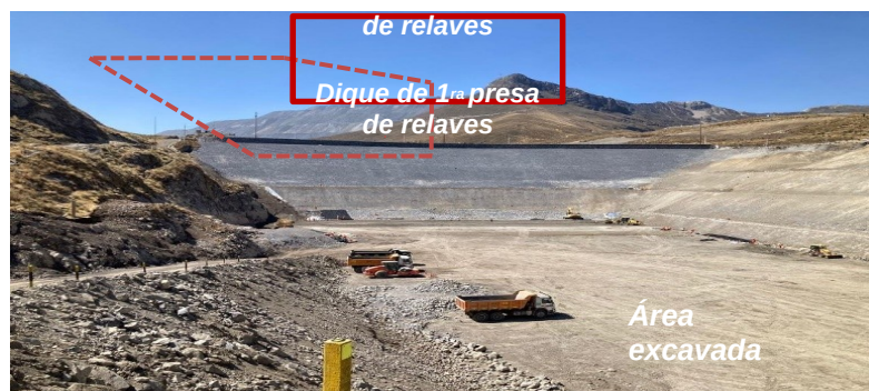
Figura 11. Excavación de vaso de la presa de relaves
