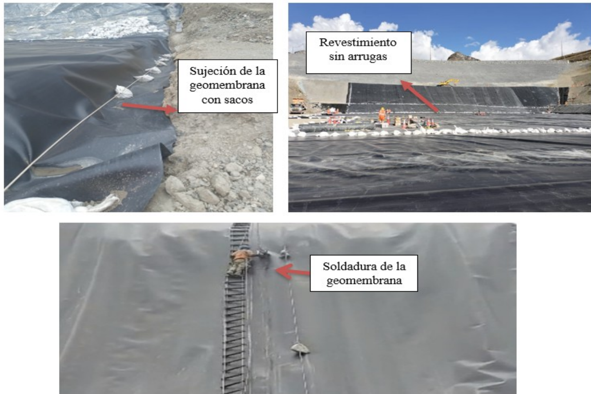
Figura 15. Revestimiento del Dique de Presa de Relaves
