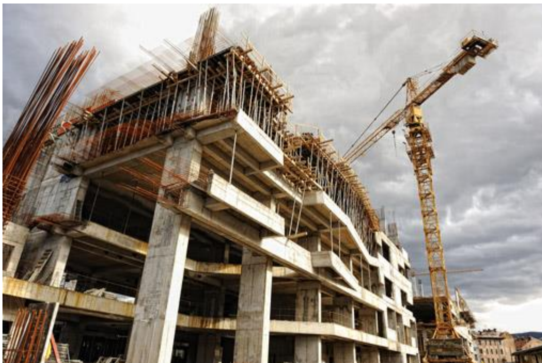
Imagen 1.- Construcción de Edificación Aporticada. Año 2012
