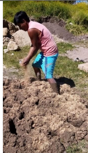
Figura 12. Incorporación de virutas en la mezcla humedecida. Fuente: Propia
