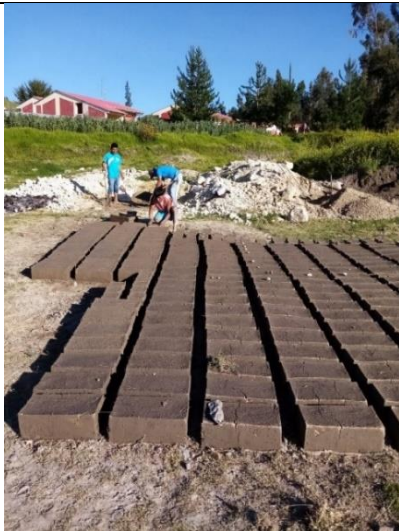
Figura 14. Fotografía panorámica de los adobes fabricados. Fuente: Propia.
