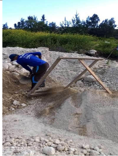
Figura 6. Proceso de zarandeo de suelos. Fuente: Propia.
