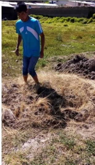
Figura 11. Incorporación de paja en la mezcla humedecida. Fuente: Propia.
